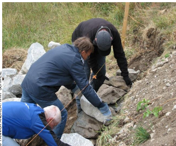
Trockensteinmauern werden ohne Mörtel gebaut
