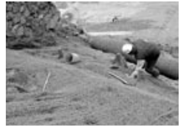
Startbereich: aufwändige Wiederherstellungs- und Begrünungsarbeiten im steilen und erosionsanfälligen Startgelände.
