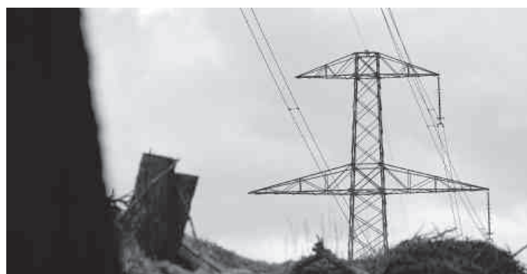
Die nur einseitig mit Leiterseilen ausgestatteten Masten werden mit einer zusätzlichen Leitung versehen und teilweise erhöht. Foto: Jon Duschletta
