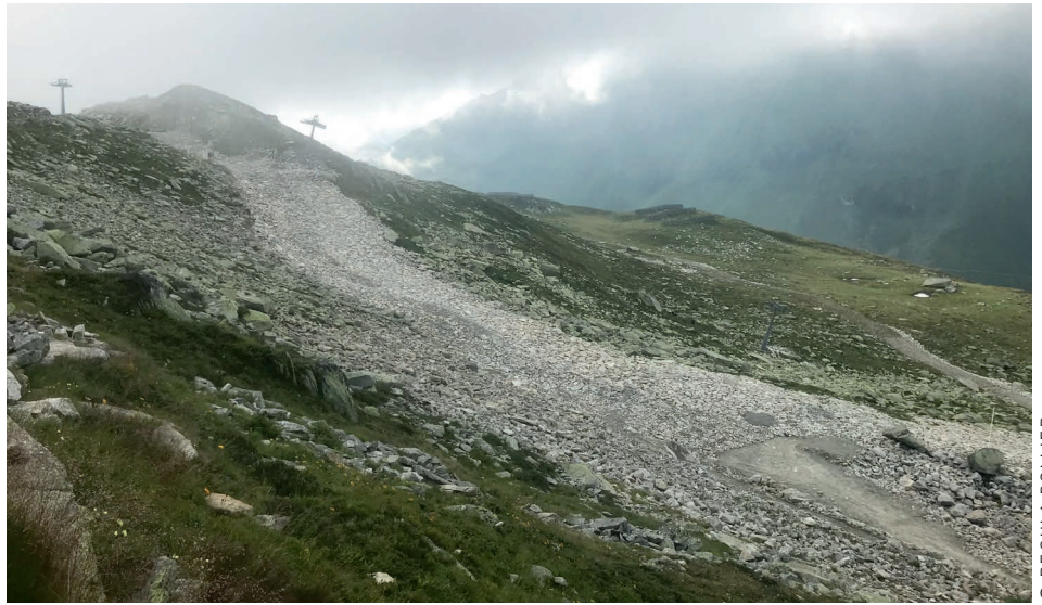
Neu gebaute Verbindungspiste zwischen Strahlgand und Ober Stafel.
